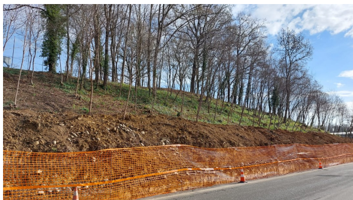
I lavori sul versante in zona Cantone Molino
